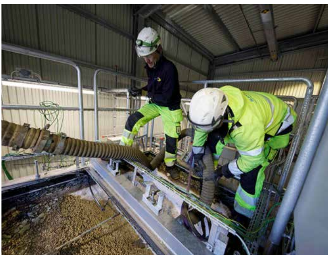
Uppsugget material kommer först in i filteravskiljarens fallkammardel, där tyngre material avskiljs och faller till botten i stoftbehållaren.
